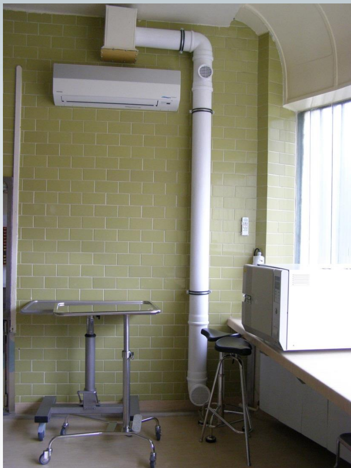
odvod vzduchu a umístění KJ
