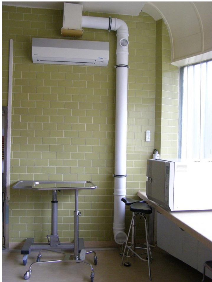
odvod vzduchu a umístění KJ
