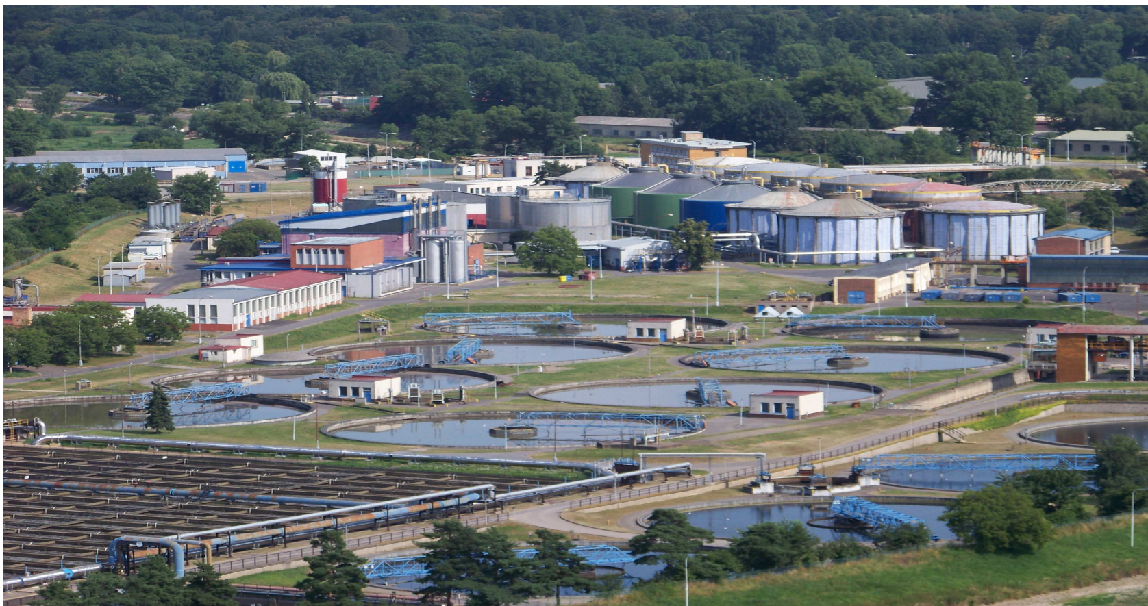
Ústřední čistírna odpadních vod v Praze 6 - Bubeneč
