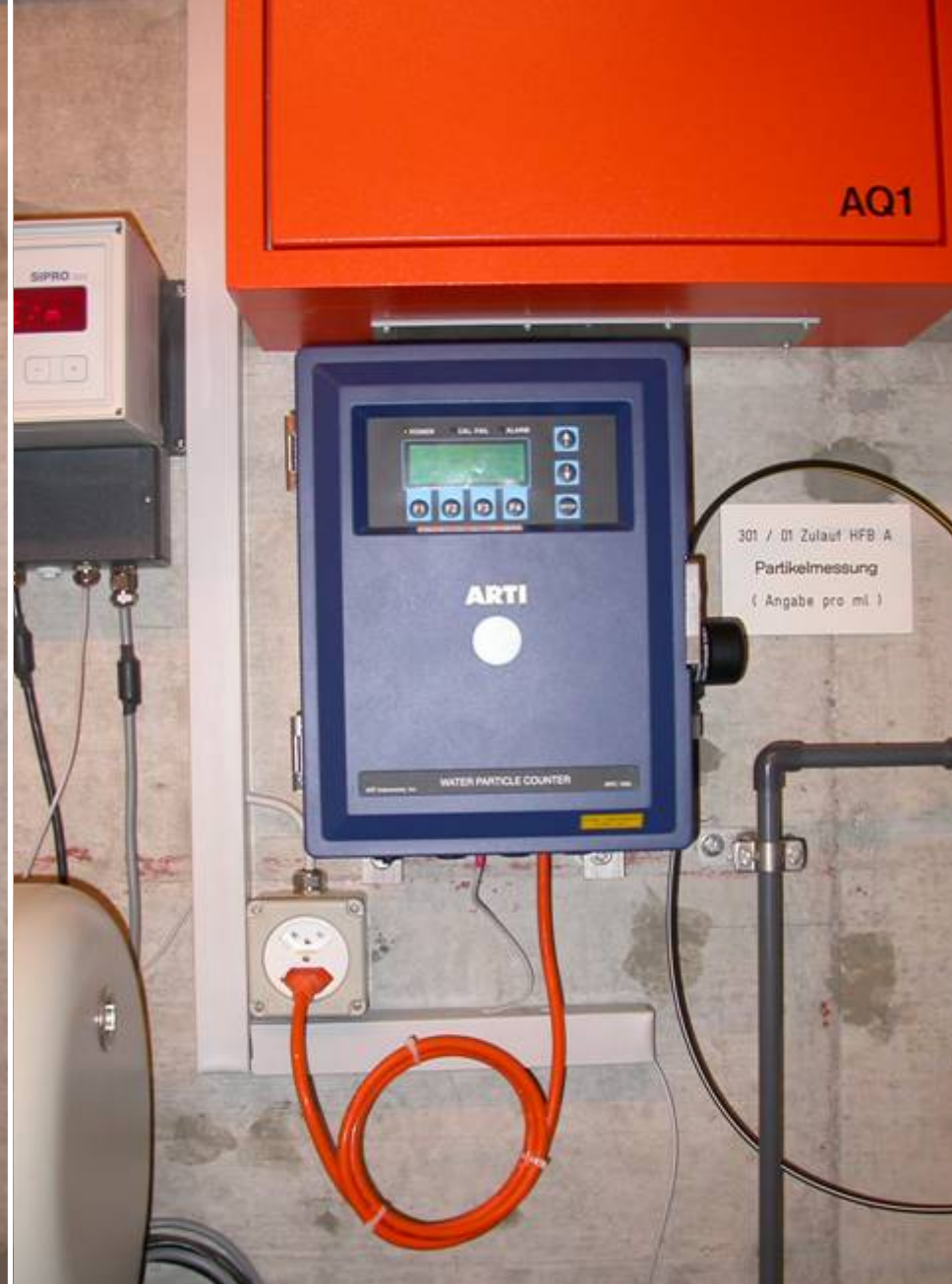
Kontinuální kontrola provozních parametrů vody ve zdroji je důležitým článkem plánů pro zabezpečení kvality pitné vody. On-line analyzátor teploty, pH, oxidačně-redukčního potenciálu, vodivosti a kyslíku (vlevo) a on-line analyzátor částic (vpravo) na vodárně v curyšském Hardhofu.
