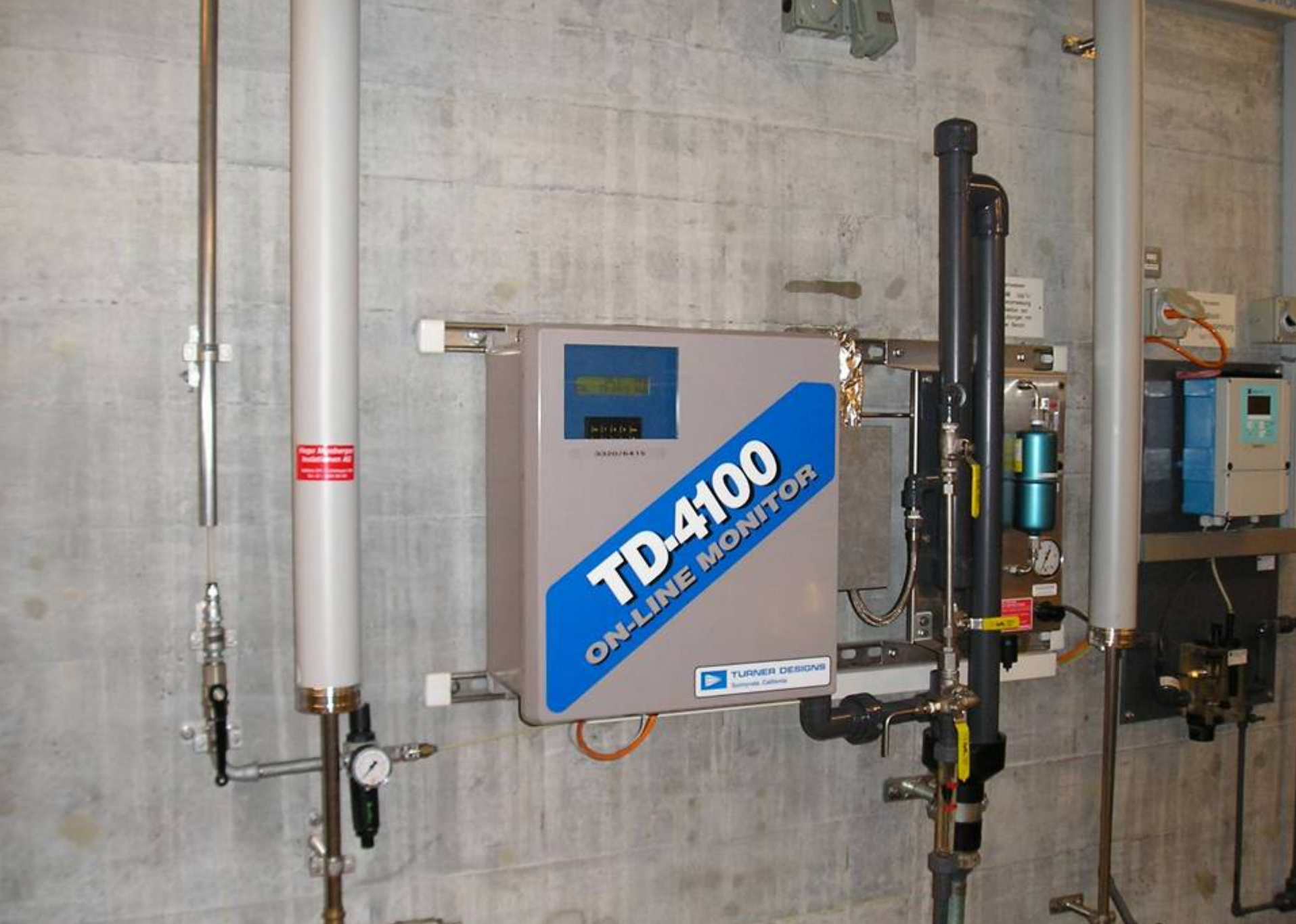
On-line analyzátor ropných látok na vodárně v curyšském Hardhofu.
