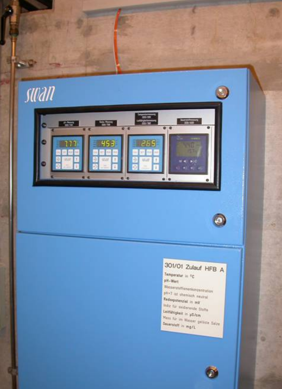
Kontinuální kontrola provozních parametrů vody ve zdroji je důležitým článkem plánů pro zabezpečení kvality pitné vody. On-line analyzátor teploty, pH, oxidačně-redukčního potenciálu, vodivosti a kyslíku (vlevo) a on-line analyzátor částic (vpravo) na vodárně v curyšském Hardhofu.
