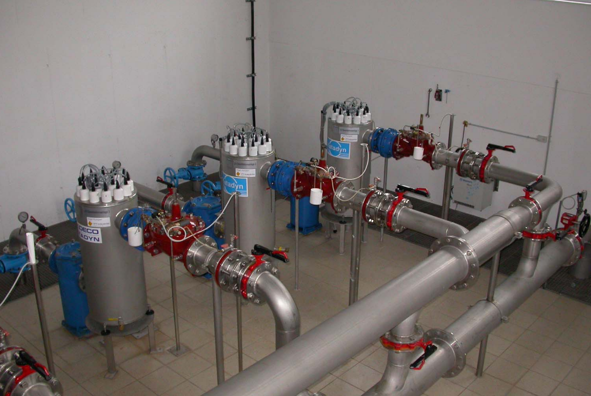
Sektor UV lamp na úpravně (I), za zmínku však stojí především dokonalá čistota podlah na všech místech úpravny.
