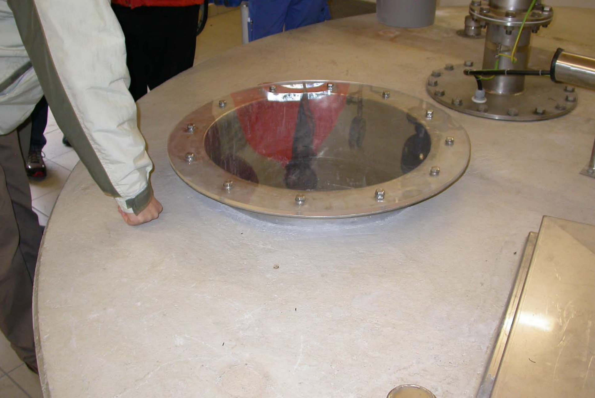
Upravené zhlaví studny s možností pohledu dolů.
