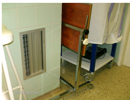
Obr. 5: Částečně uzavřená odváděcí vyústka
